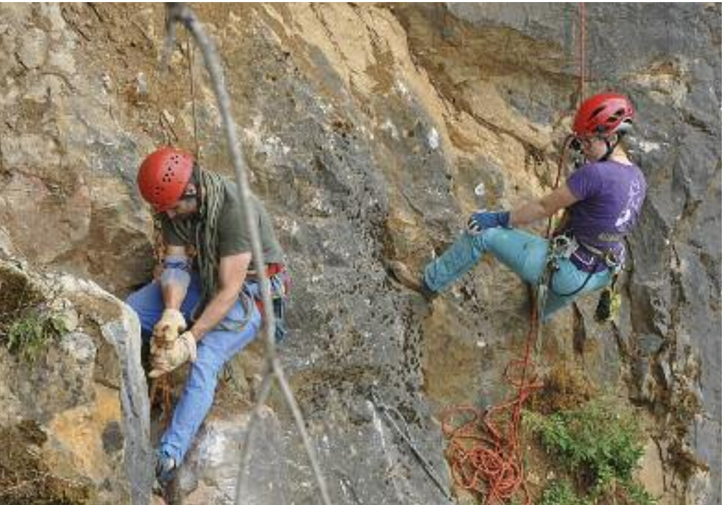
Mit Brechstangen wird brüchiges Gestein entfernt
