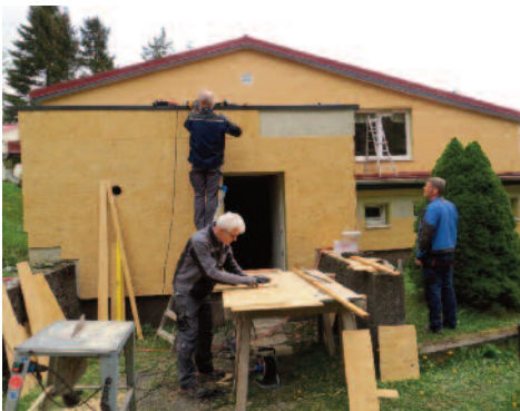
Verkleidung mit PREFA-Elementen, westliche Seite der Hütte, Mai 2016
