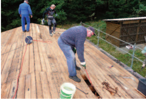
Dacherneuerung des Nebengebäudes, September 2014
