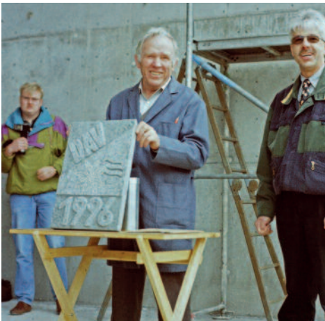
Der damalige Vorsitzende Willi Klenner zusammen mit dem Steinmetz bei der Grundsteinlegung
