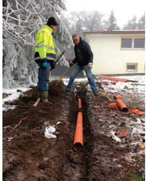
Erneuerung des Dachrinnenabflusses von der Hütte bei widrigen Verhältnissen
