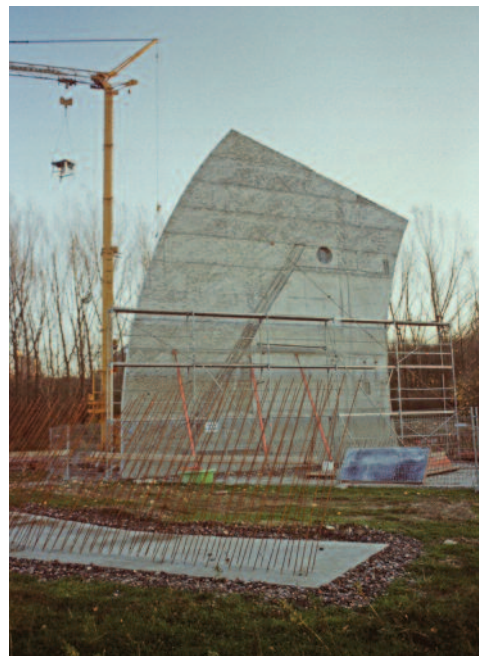
Zuerst wurde die senkrechte Hauptwand errichtet.
