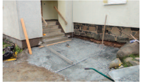
Erneuerung Eingangsbereich Hütte, April 2014
